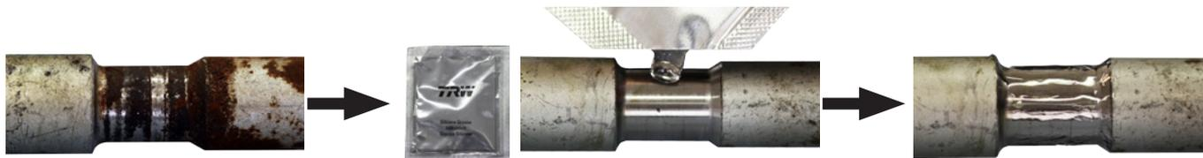
Les surfaces d'étanchéité doivent avoir été nettoyées et être exemptes de toute trace de corrosion avant le montage des joints-soufflets. En vue d'optimiser l'étanchéité, la graisse à base de silicone fournie doit être appliquée sur la surface d'étanchéité de la barre de connexion. Toujours utiliser les nouveaux accessoires fournis.
